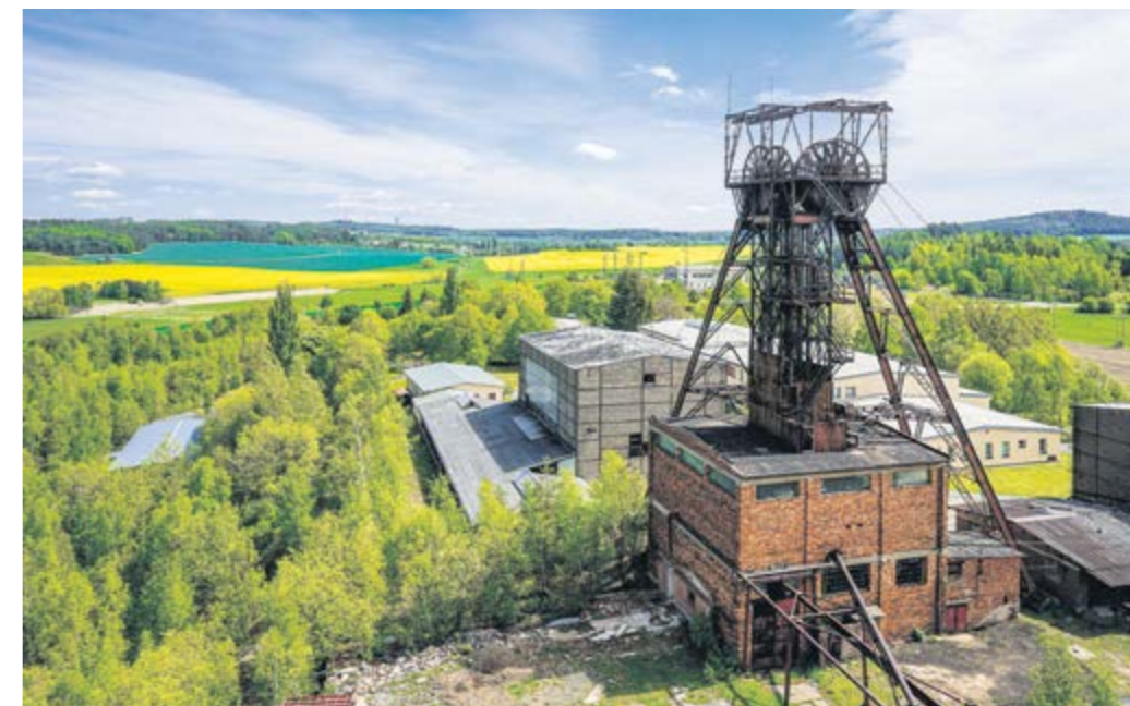
Těžní věž šachty c15. Foto zdroj: DIAMO
